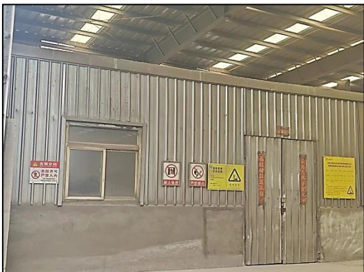
危废暂存间外
